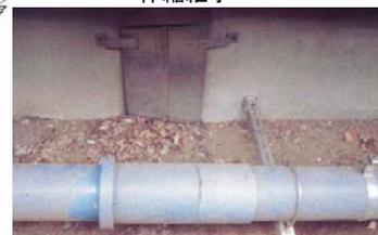
写真-5 伸縮継手の設置状況
