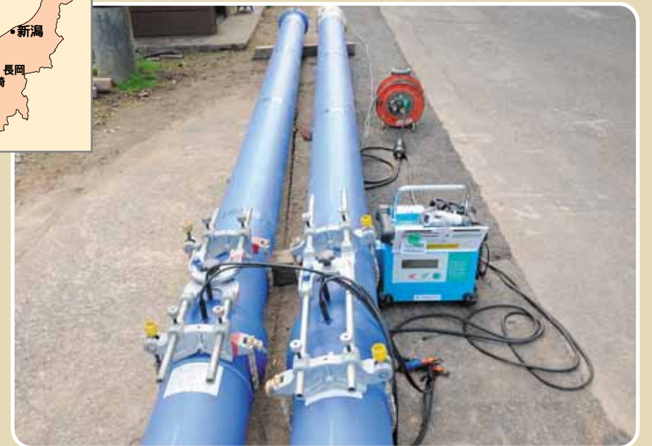
水道配水用ポリエチレンパイプEF片受直管呼び径200の片受口2個同時通電中
