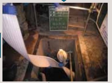
帯板(ストリップ)をマンホールから既設管内に引き込む。
