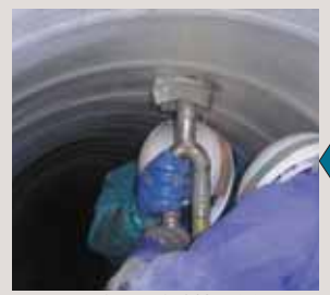
スペーサー部から充填材を注入し、ストリップと既設管を一体化させる。
