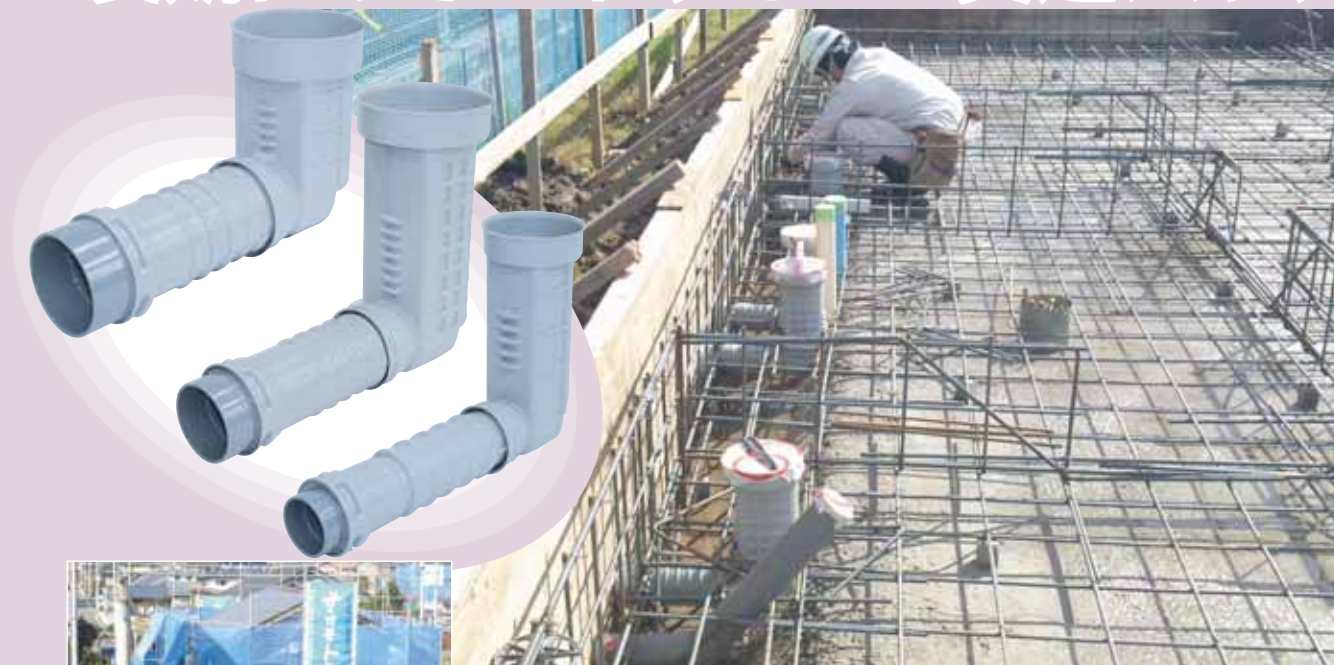
KC貫通パックの3サイズ[Pack50、Pack75、Pack100]の施工が進む。手前のVU45L+塩ビ管(さや管)は、追炊き用ベアーチューブ等を更新可能にする。
