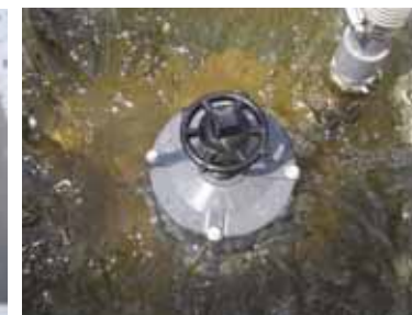
代かき時など大量の水を使うときは、逆流防止柵を取り外す。
