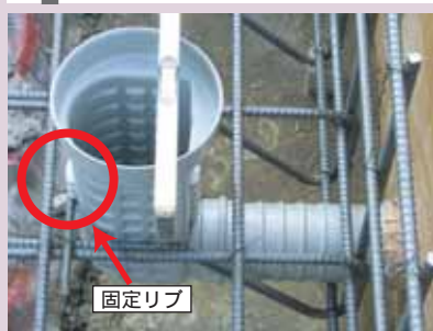
KC貫通パックのさや管の固定リブ(写真左)に鉄筋がしっかりと固定される。
