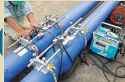
出力ケーブルの接続 EF片受直管の受口端子に片受口同時通電ケーブルを接続する。
