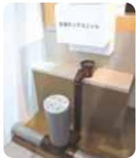
貯湯タンクユニットからの高温排水を処理する高温排水システム。
