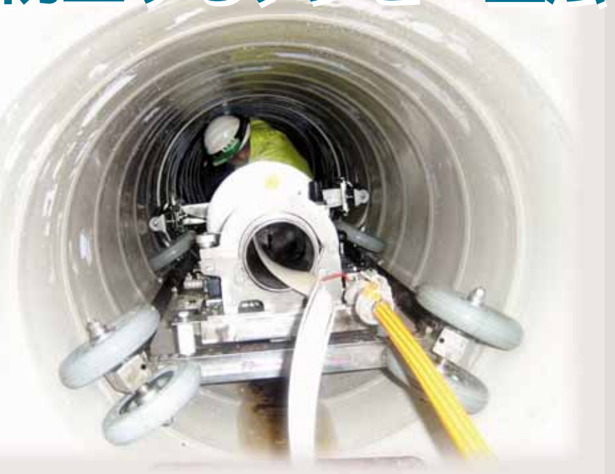
製管機で嵌合部材(ジョイナー)を帯板(ストリップ)の間に固定していく。
