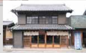
奥順株式会社の奥順店舗 木造2階建ての1階が店舗と奥が旧住居部、2階は12畳の座敷。
