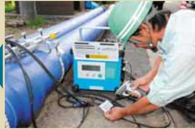
バーコードリーダーによる読みとり 融着データを読み込み。
