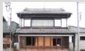
奥順株式会社の蔵 蔵2階建てで、棟は箱棟で両端に影盛を付けるなど、典型的な関東の見世蔵形式を示している。
