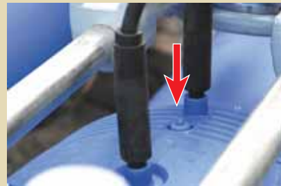
通電の完了 8分少々で通電が終了し、インジケータの隆起を確認。
