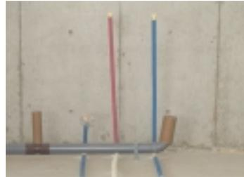
キッチンの水周り。左から食器洗浄器の給水、シンクの給湯、給水
