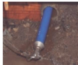
地震で破損した既設管を復旧させるパイプインパイプ工法(北海道池田町)
