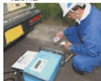
EF接合は新しいJWWA規格用共用型EFコントローラで。
