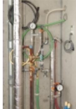
配管施工終了後各パイプには水圧が加えられ、漏水のチェックが行われる。
