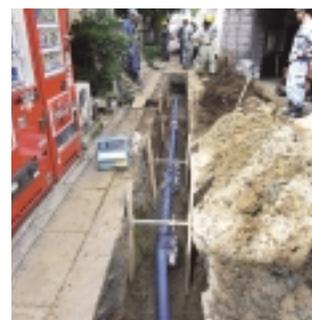
施工性、耐震性、耐食性を検証する試験施工(東京都品川区)
