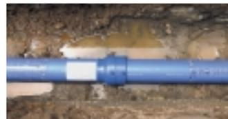
使用されたのはEF片受直管 100。酸性土壌のため土は赤っぽいですが、水道配水用ポリエチレンパイプは腐食の心配がない。
