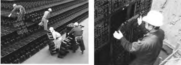
組立て作業の様子
