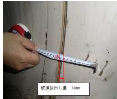
写真 2-4 破損箇所④
