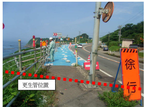
写真 2-9 SFジョイナーによる変位吸収箇所
