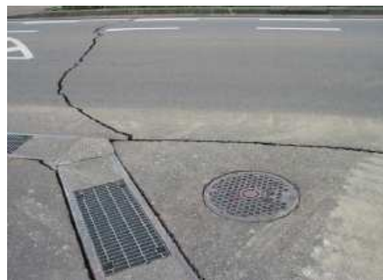
写真 2-6 人孔周辺地表部の状況
