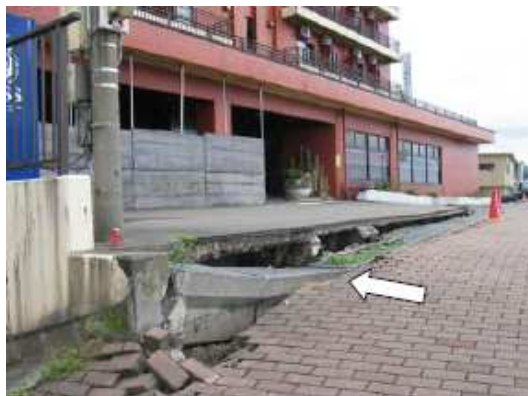
写真 2-5 歩道部の段差
