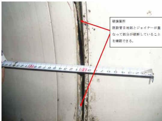
写真 2-3 破損箇所③
