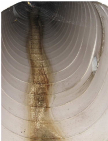
写真 2-10 更生管内状況（施工箇所②）
