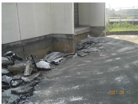
写真 2-7 八坂中継ポンプ場における地盤沈下と復旧工事
