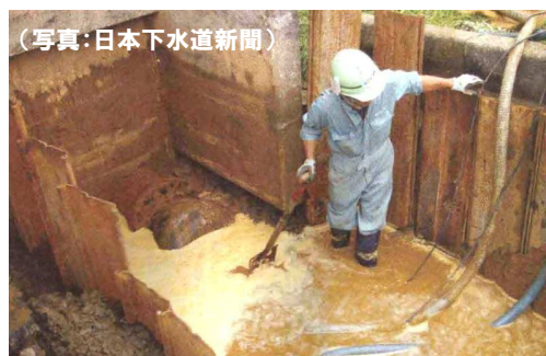
写真 2-7 八坂中継ポンプ場における地盤沈下と復旧工事
