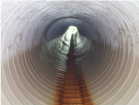
写真 2-8 更生管内状況（施工箇所①）
