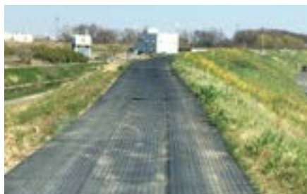
河川専用道路の重機搬入
