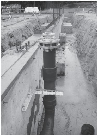
写真2 採用事例②物流倉庫の屋外消火栓設備
