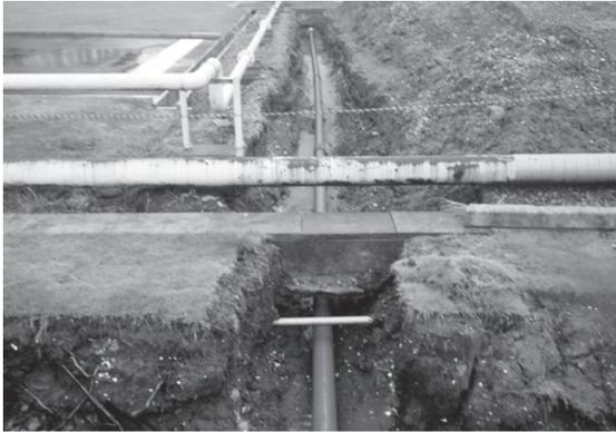
写真1 採用事例①化学工場の屋外消火栓設備
