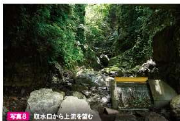
写真8 取水口から上流を望む
