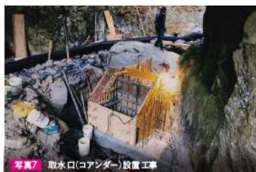
写真7 取水口(コアンダー)設置工事
