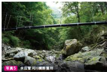
写真5 水圧管河川横断箇所
