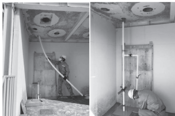
写真1 床スラブ区画貫通検証（縦管呼び径50）
