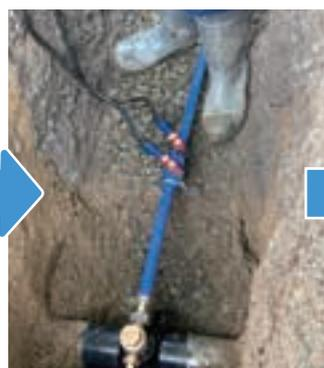
SPユニオン継手とスーパータポリ1種管ブルーの電気融着
