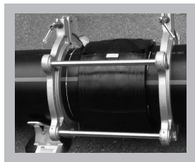
管と継手の固定(クランプ)
