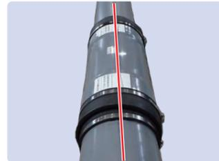
さや管が挿入されている管と継手が一直線であることを確認する。
