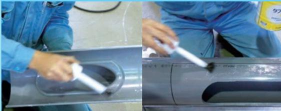
接合面（分岐管内面及び管外面）に接着剤を素早く塗布します。(2度塗り)
