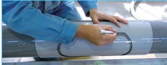
けがき・開孔ゲージの標線を管頂に合わせて、油性ペン等で開孔部をマーキングします。
