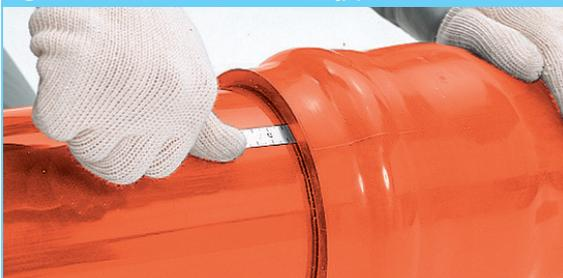
管挿入後、全円周にわたってゴム輪が正常な状態かどうかチェックゲージで確認します。異常が認められた場合は直ちに管を抜き、作業をやり直してください。
