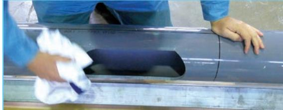
開孔部にできた大きなバリはヤスリ等で取り除き開孔作業で生じた切粉を綺麗に取り除きます。
