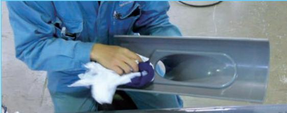
管や分岐管の接合面を清潔なウエスで十分清掃し、付着している泥やホコリをしっかりと落とします。
