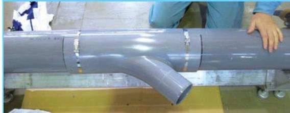
すみやかに分岐管を管開孔部に取付け、SUSバンドを締め付け固定します。(注意 3)
