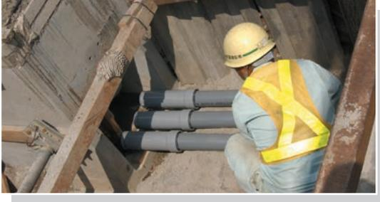
■ 電力ケーブル保護管に滑剤を塗り接合
