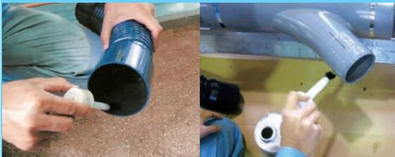
コルゲート管が管軸方向と垂直になるように、分岐管に接着接合します。
