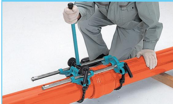
管軸を合わせ、標線まで挿入します。(注意 2)
