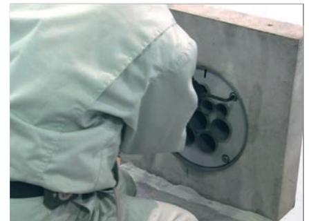
① ハンドホール内からボルト固定式ロータス管を挿入します。
