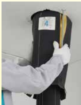
④新たに入れた切込み側を上にして、グラスウールが内側になるよう集合管下部にセットします。
