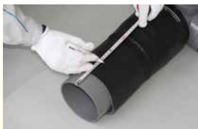
① プレ遮音シートに標線を記入します。
