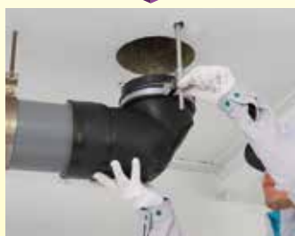
③ VCLベンド支持金具両端のボルト通し穴に、①の全ねじボルトを通し、ベンド本体を吊り下げ、設置レベルを調整します。
