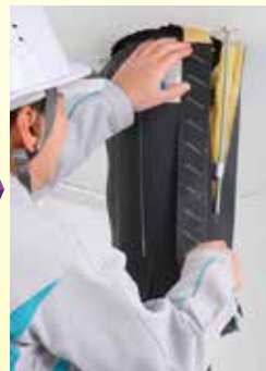
⑥切込み部に、遮音シート専用固定テープ(別売)を貼り付けます。
