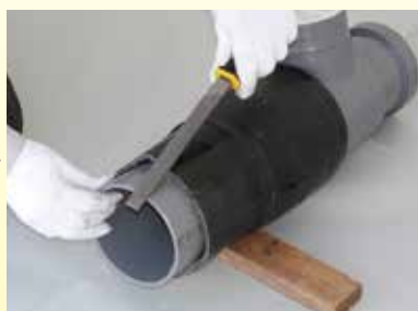
⑤ ディスクグラインダー、またはヤスリで切断面の面取りを行います。
