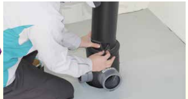
②遮音シート専用固定テープを使用して、補修します。
