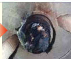
試験後の加熱側の状況
