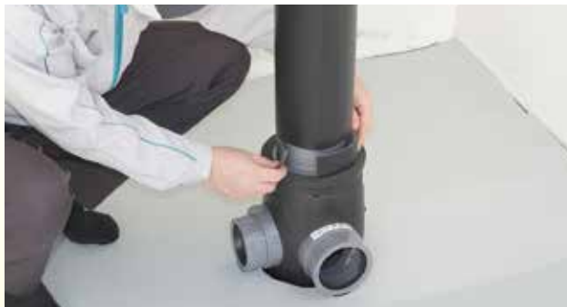
①立て管または集合管の切断後にプレ遮音シートのすき間が空いてしまった場合、切断したプレ遮音シートを用意します。 ※補修用のプレ遮音シートは、すき間に対して大き目のサイズに切断してください。
