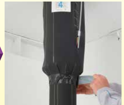
⑦集合管と直管の段差部分は、遮音シートの切込みを利用して径を絞リ、遮音シート専用固定テープ(別売)を巻き付けて固定します。固定テープの長さは、60cm×2巻を目安としてください。
