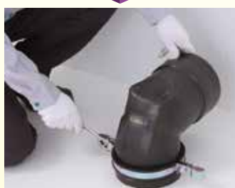
② ベンド本体の立て管受口部分 (上端の4つの突起の直下) に専用支持金具 (別売) を取付けます。
