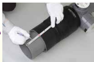
③ 下部差し口に切断線を記入します。
