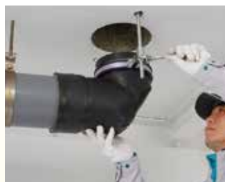
④ 上下の六角ナットを締め付けて固定します。
