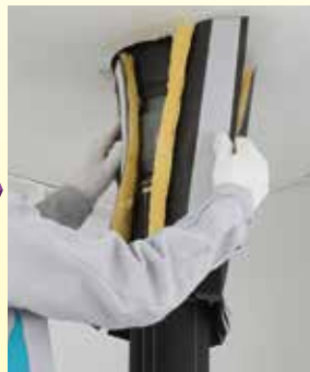
⑤新たに入れた切込みから、支持金具付高ナット・全ねじボルトを外側に出し、面ファスナのオス・メスを重ね合わせて巻き付けます。
