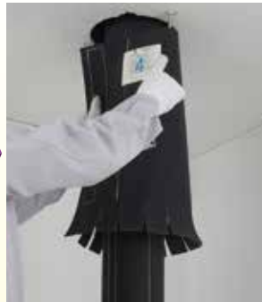
②遮音シートの切込み側を下にして仮合わせを行い、支持金具を外に出すために新たに入れる切込みの位置を確認します(上図参照)。
