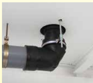
③ VCLベンド支持金具両端のボルト通し穴に、①の全ねじボルトを通し、ベンド本体を吊り下げ、設置レベルを調整します。
