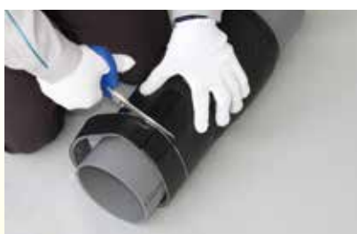
② 標線の位置でプレ遮音シートを切断して剥がします。 ※カッターで切断する場合、塩ビに傷がつかないように注意してください。
