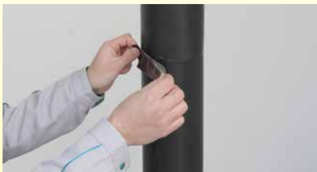
①切れ目程度の傷は遮音シート専用固定テープで補修します。塩ビ部分が剥き出しになるような傷は、プレ遮音シートを傷の形状に合わせて切断し、遮音シート専用固定テープで補修してください。
