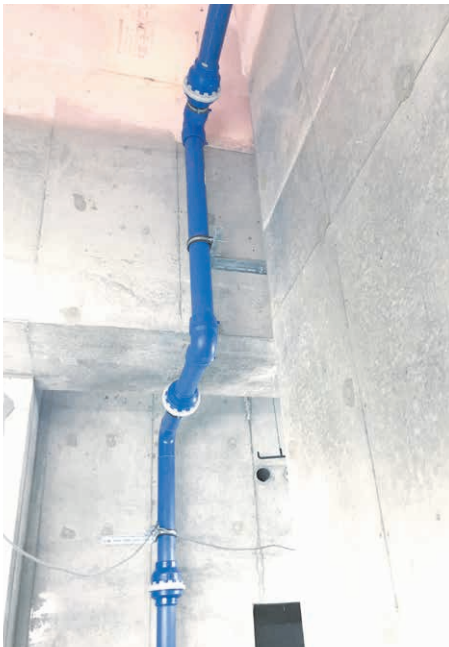
Eロック接合 (天井配管)
