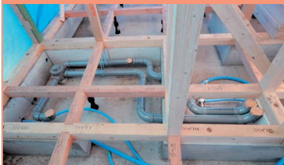
1階部分の排水管全景
