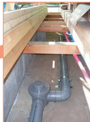
2階のトイレの汚水とキッチンの雑排水を集水
