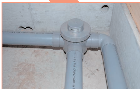
キッチン以外の1階、2階の汚水・雑排水を1階床下で集水
