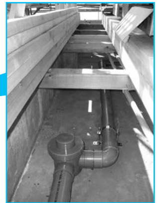
2階のトイレの汚水とキッチンの雑排水を集水
