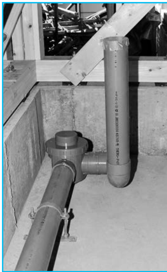
1階のバス、洗面、洗濯機の雑排水とトイレの汚水を集水
