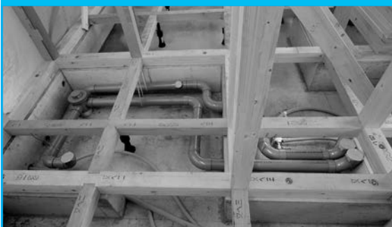
1階部分の排水管全景
