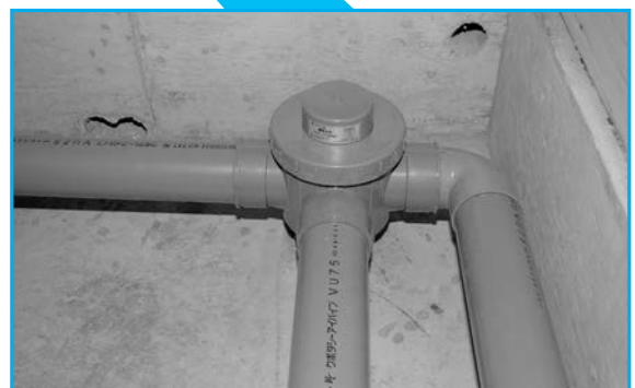
キッチン以外の1階、2階の汚水・雑排水を1階床下で集水
