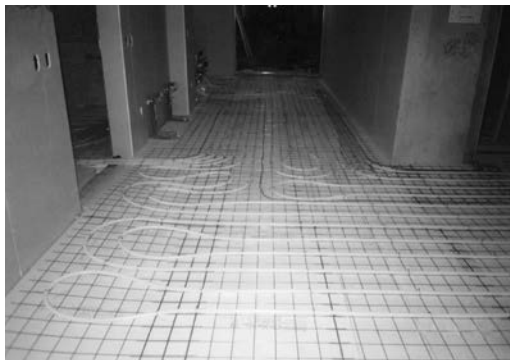
床暖房配管施工実例
