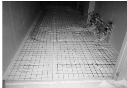
床暖房配管施工実例
