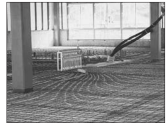
<床暖施工写真>
