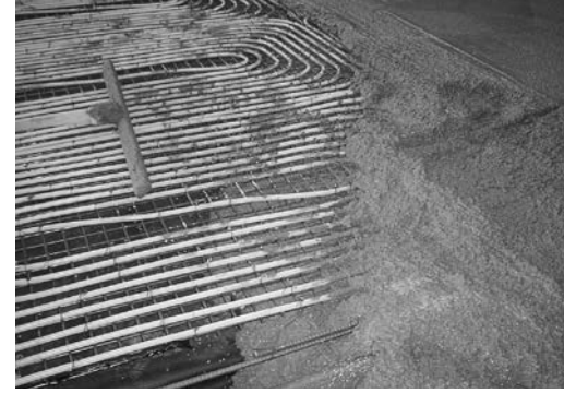
融雪配管施工実例
