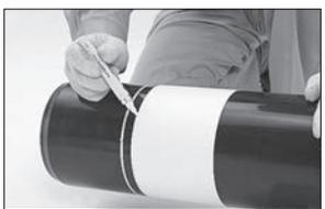
管端の仕上げができると、管挿し口に挿入長さを表す標線を油性ペンなどで記入します。
