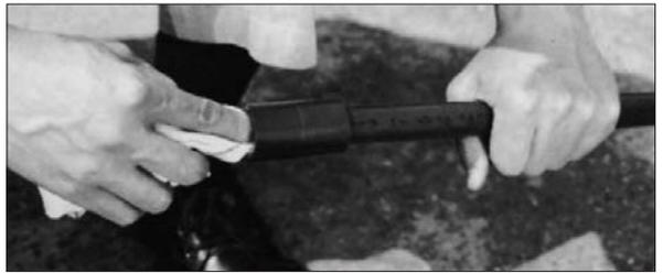
受口内面と挿し口外面を乾いたウェスできれいに清掃してください。接着面が汚れていると、接合部の漏水や抜け事故につながりますので、注意してください。油などが付着しているときは、エタノールなどを少量つけてふきとってください。なお、現場では油や水分の付着した手袋を用いて、逆に接合面を汚すことがありますので、十分に注意してください。
