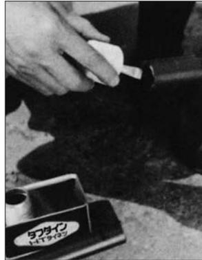
接着剤は、必ずタフダインHTを使用し、他の接着剤を使用しないでください。接着剤は、継手内面、管挿し口の順に、薄く均一に塗布してください。継手内面の塗りすぎは、接続により接着剤が管内部に押し出されて、亀裂事故(ソルベントクラッキング)が生じたりすることがありますので、避けてください。
