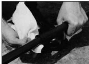
挿し込み後、管の抜け出しを防ぐため、下表の時間だけ挿し込み力を保持してください。
