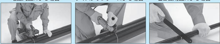
切断線を目安に、管軸に対して直角に切断します。
