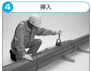
接着剤を塗り終わったら、直ちに管軸を合わせて標線まで一気に挿入し、そのまま保持します。
