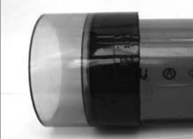
・管端面が継手ストップバーまで挿入されていない場合は、継手を切断して新しい継手で再施工してください。
