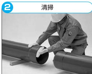
受口内面および挿し口外面を乾いたウエスなどで清掃します。なお挿入機およびワイヤー等は予めセットしておきます。
