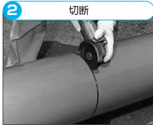
管軸に対して直角に切断します。
