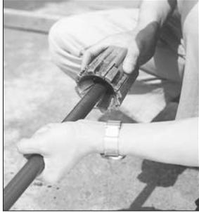
切断により内外面に生じたバリ・カエリを取りのぞくため、面取り器またはヤスリで面取りを行います。
