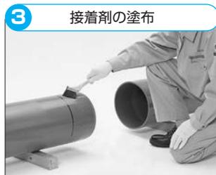
受口内面、挿し口外面の順に、薄く塗りムラのないよう円周方向に均一に接着剤を塗布します。
