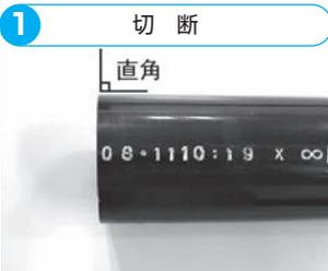
全周にわたって切断線を記入し、塩ビ管用鋸等を用いて管軸に対し直角に切断します。
