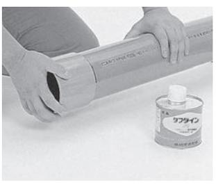
②接着剤を、まず継手内面に、次に管挿し口に薄く均一に塗布します。呼び径が大きい場合は、接着剤を別の金属容器に必要分だけ取り出し、大きな刷毛を用いれば作業能率があがります。その際の刷毛は動物毛を使用してください。プラスチック製は溶けて接着力を低下させます。
