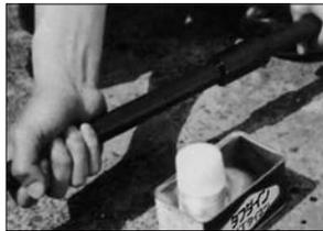
管を継手受口に軽く挿し込み、ねじれが出ないように位置・方向を確認して、管軸を合わせて一気に呼び径 40 以下は受口長さℓ標線に向かって、呼び径 50 以上は 1/3ℓ標線を越えるまで挿し込みます。
