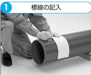
挿し口に挿入長さを示す標線をマジックインキで記入します。
