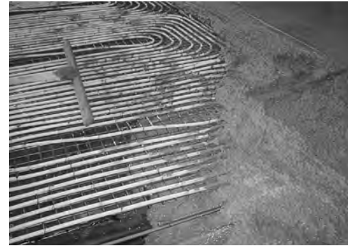
融雪配管施工実例
