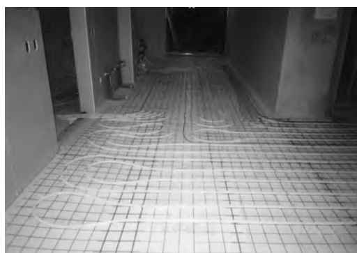
床暖房配管施工実例
