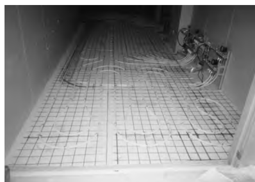
床暖房配管施工実例
