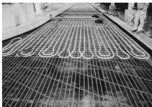
融雪配管施工実例
