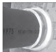
鋼製スリーブ設置状況 (シリコン充填)
