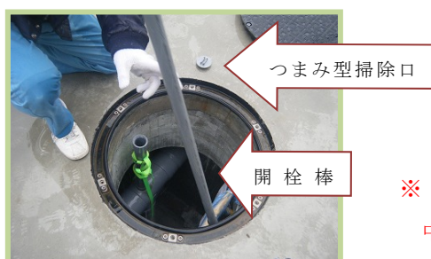
図 9-2. 下部キャップ取り外し作業準備
