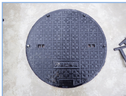
図 10-9. 铸铁蓋の取付け
