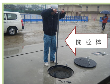
図 9-3. 下部キャップ取り外し作業
