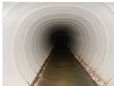
更生管内状況
