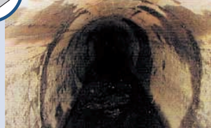
馬蹄形きよの施工事例
