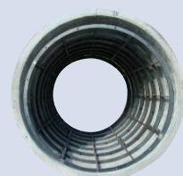
鋼製リング補強
