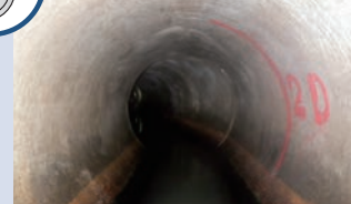
曲管の施工事例
