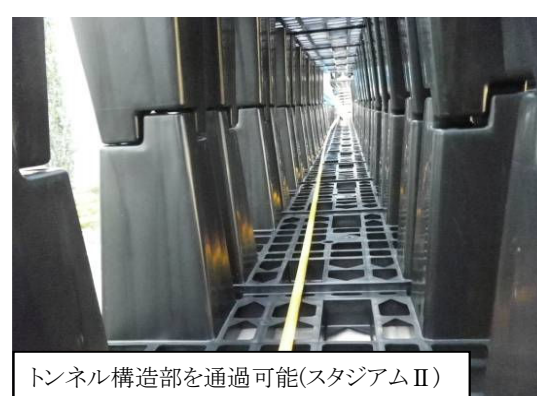
写真 5 - 2 通線ワイヤーによる通線状況
