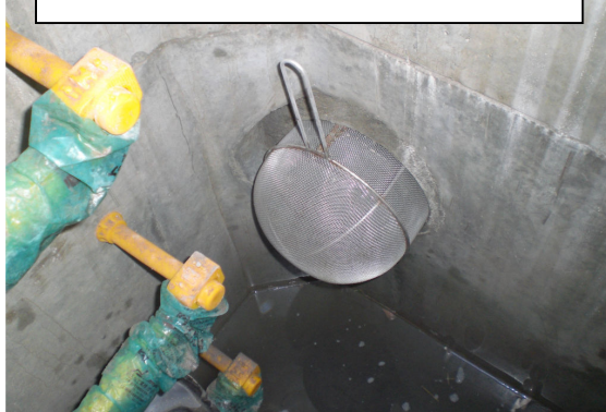
流入人孔 フィルター、泥溜めの確認
