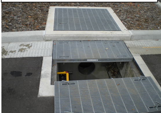
流出人孔 落葉、ゴミ堆積状況の確認
