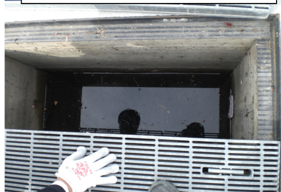
泥溜め、流出管、オリフィスの確認
