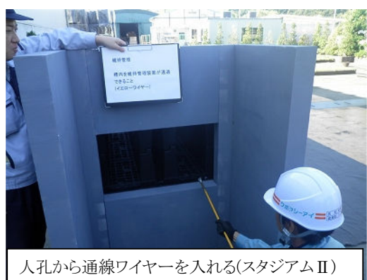
写真 5 - 2 通線ワイヤーによる通線状況
