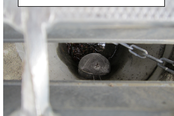
流入ます フィルター、泥溜めの確認
