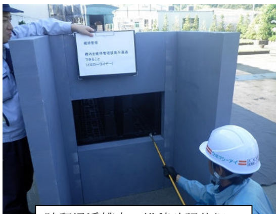
貯留浸透槽内の堆積確認状況
