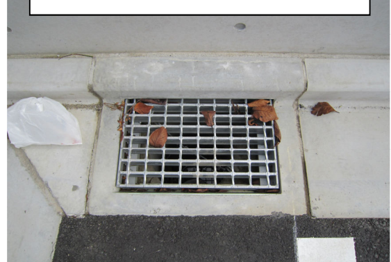
流入ます 落葉、ゴミ堆積状況の確認
