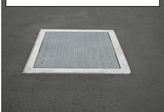
流入人孔 落葉、ゴミ堆積状況の確認
