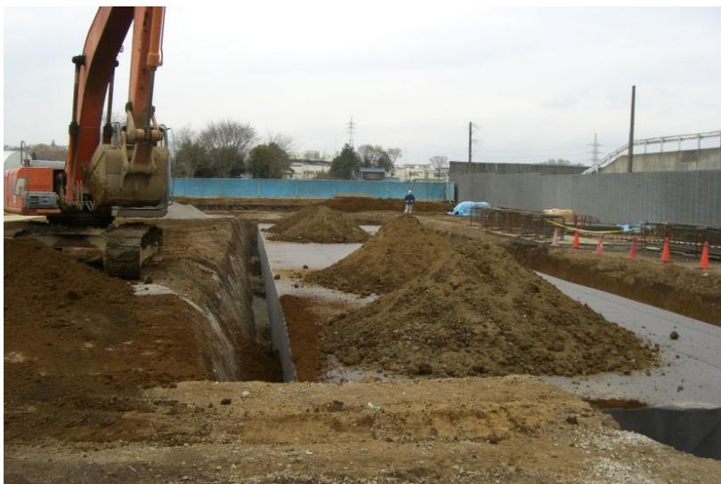
図－ 2 1 埋戻し時の置き土状況
