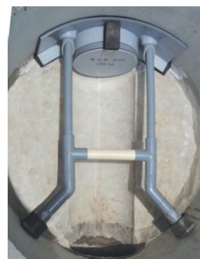
φ500設置状況
