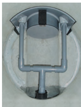
φ350設置状況
