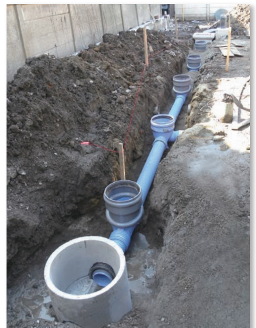
配管部分の完成
