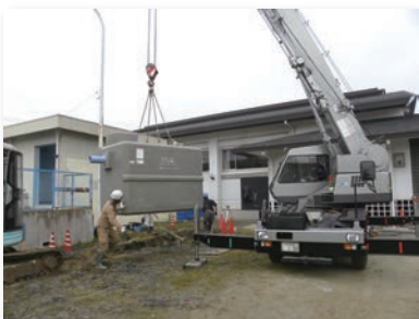
クレーンでの積み降ろし
