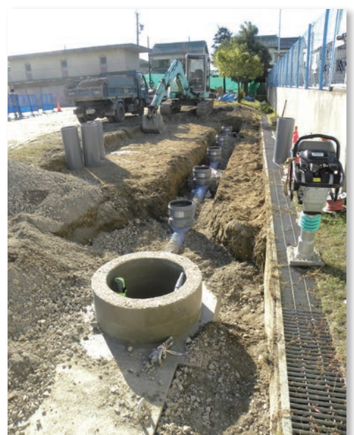
配管部分の完成
