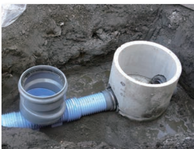
汚水ますとリブパイプの接合
