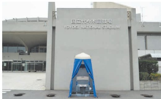
テント設置、マンホールトイレ蓋開放状態
