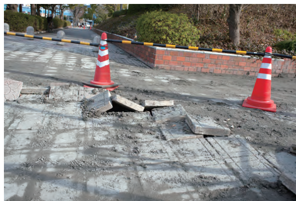
▲地震による液状化現象
