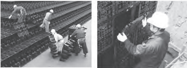
組立て作業の様子
