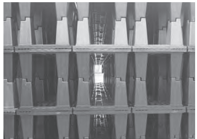
広いトンネル構造
