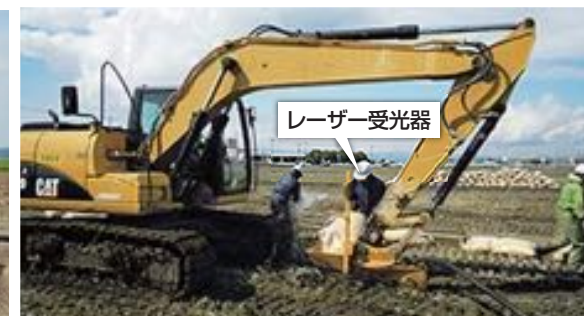
アーム式ベストドレーン施工
