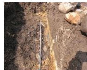
石混じりでも施工可能
