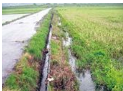
現場写真①
