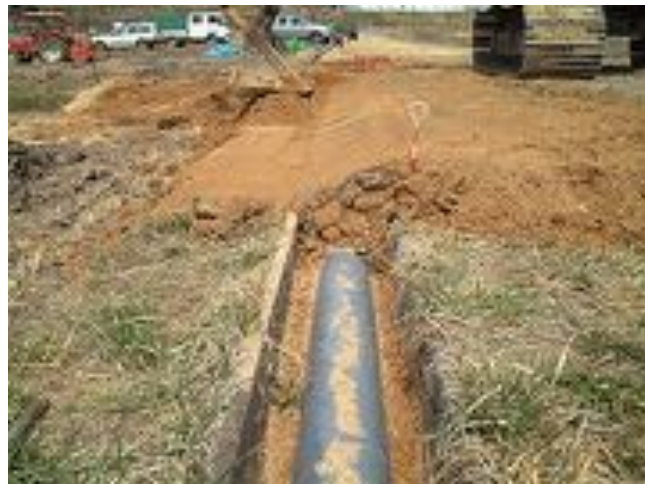
現況用水路にパイプを敷設
