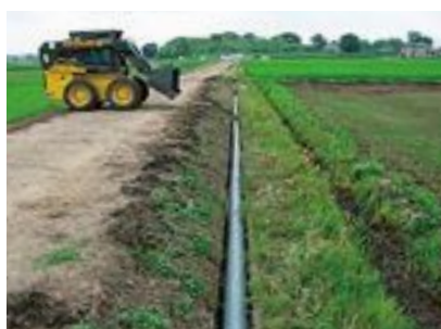
U字溝への硬質ポリ塩化ビニル管設置②
