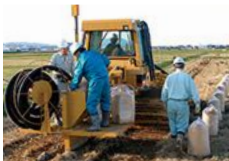
ベストドレーン施工
