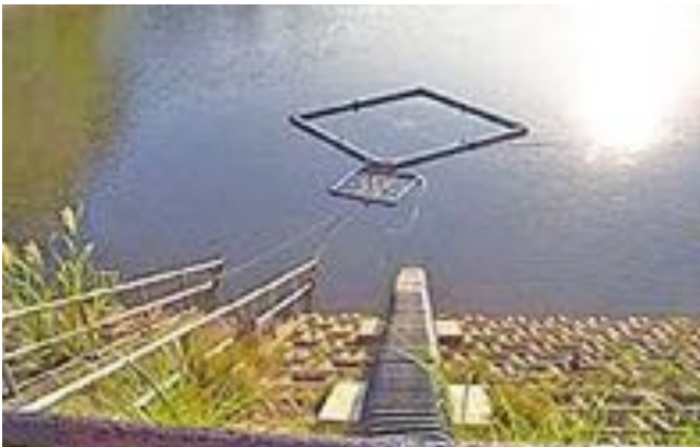
取水フロートと抜気フロート
