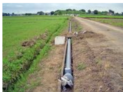
不陸対策としてGベントの設置③
