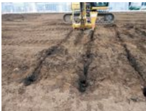
補助孔施工
