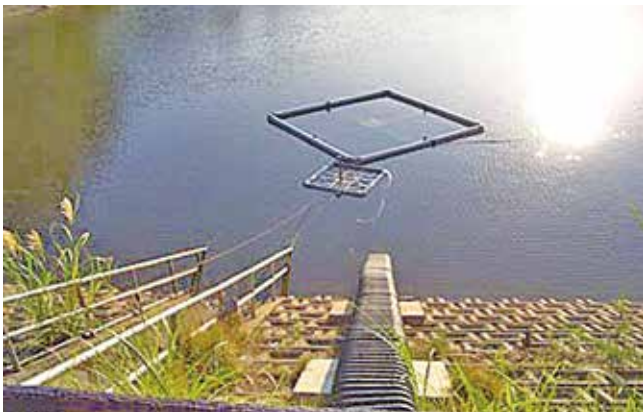
取水フロートと抜気フロート
