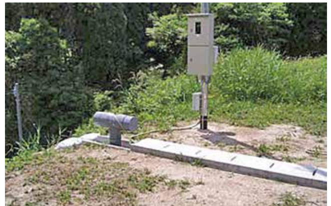
制御盤と気体捕捉タンク
