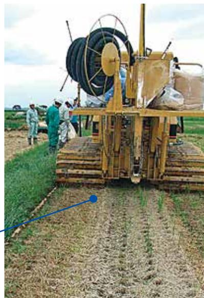
ベストドレーン工法の本暗渠 PE 布設機を併用した設計。
