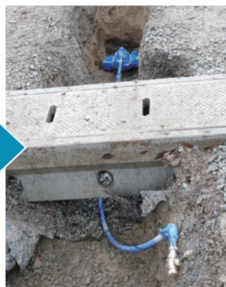
止水栓までの配管完成
