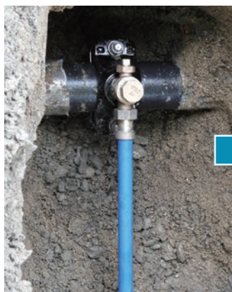
SPユニオン継手の取付け完了
