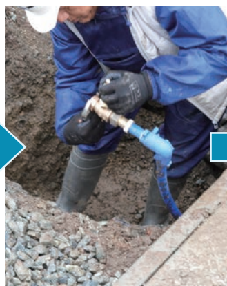
甲形ボール止水栓の取付け
