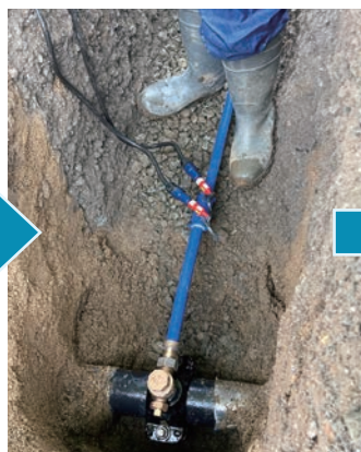
SPユニオン継手とスーパータフポリ 1種管ブルーの電気融
