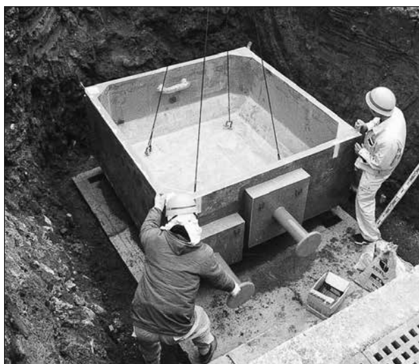
減圧水槽下部ブロックの吊り下し
