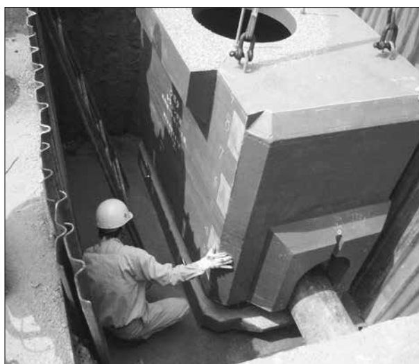
既設管への上部ブロック据え付け
