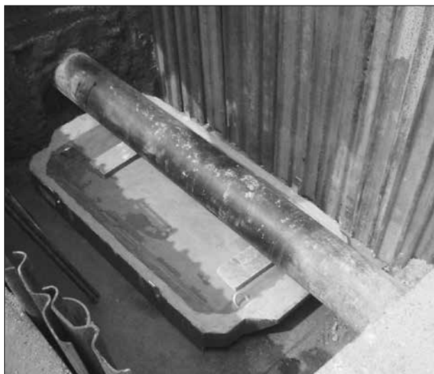
既設管への下部ブロック据え付け
