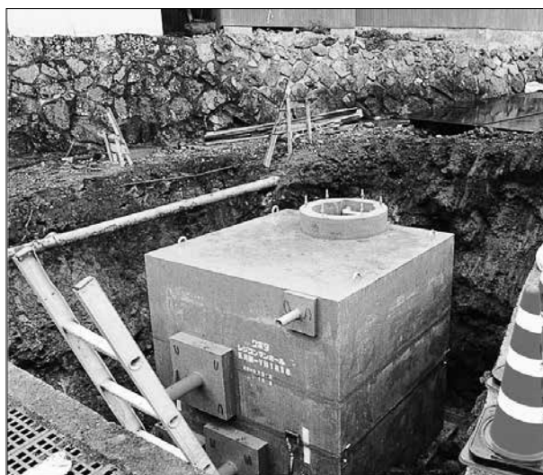
減圧水槽の設置
