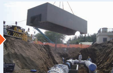
③上部ブロック据え付け
