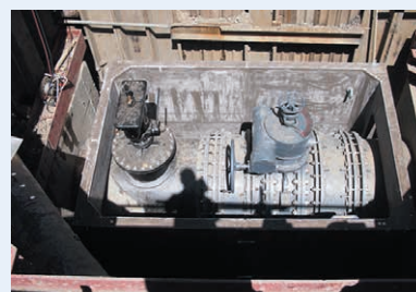
機器据付状況
