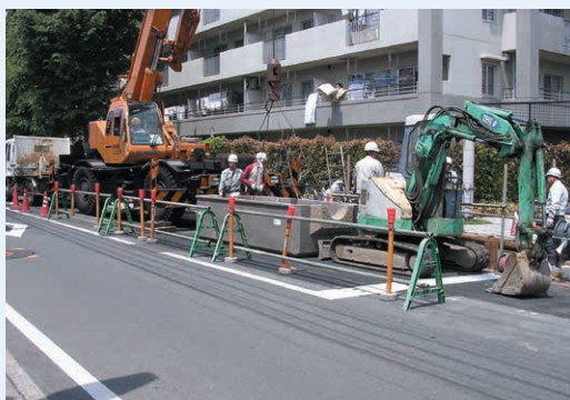
市街地での施工
