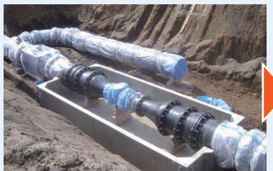
①下部ブロック設置と配管
