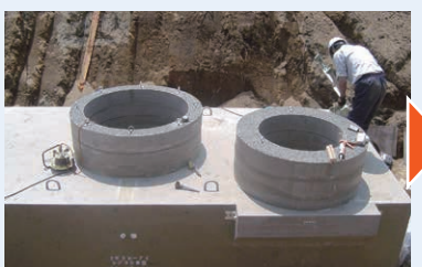
④調整リング設置(接着)
