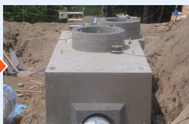
⑤設置完了
