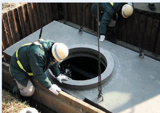
狭隘地での施工
