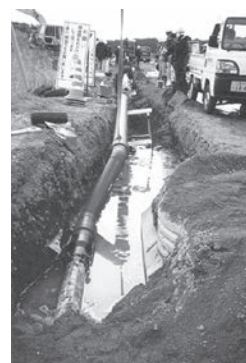
湧水の多い現場の施工例
