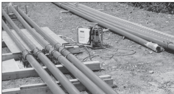
作業場での長尺管の製作
