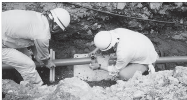
掘削溝内でのソケット接合作業(融着面の切消)
