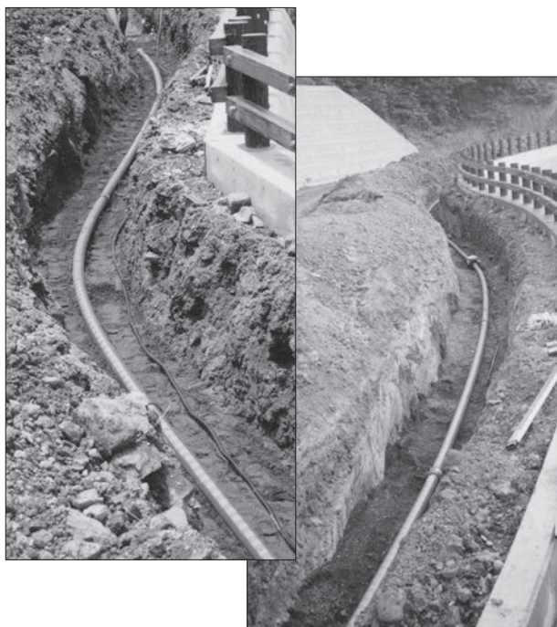
直管による曲げ配管
