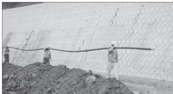
長尺管の小運搬
