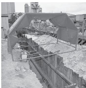
雨天時の施工例
