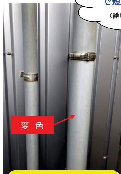
VP100 【施工後約 2 年経過】
