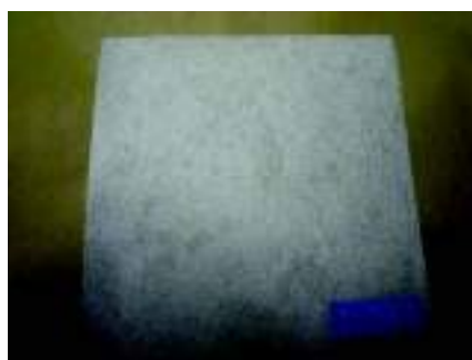
【 床用シートを張り付け 】
