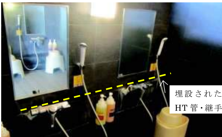
多栓分岐配管で漏水事故が発生した浴場
