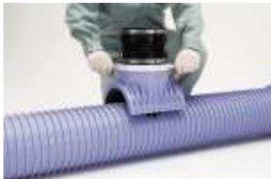
ゴムパッキン部に滑剤(V字型)を塗布し、クイックブランチをせん孔位置に合わせてセットします
