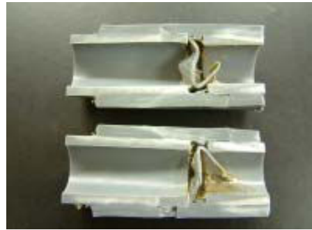
例2. 面取り忘れによる接着剤の膜張り
