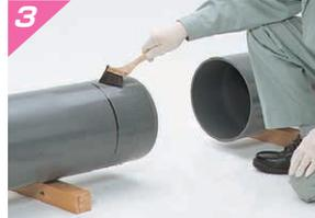
受口内面、挿し口外面の順に、薄く塗りムラのないよう円周方向に均一に接着剤を塗布します。
