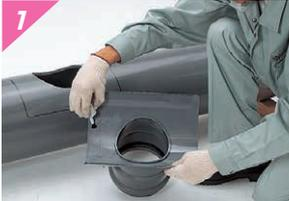
支管のくら裏面および本管の支管取付け範囲内を十分に清掃します。
