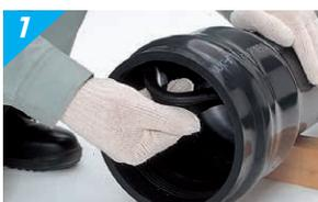
ゴム輪の汚れがひどい場合は、ゴム輪を取外し、ゴム輪溝に付着した土砂をウエスなどで拭取ってください。原則としてゴム輪を外さずにゴム輪内周面を清掃するだけで十分です。
