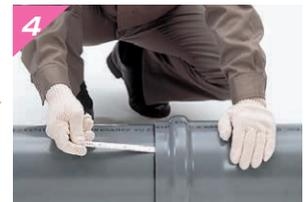
管挿入後、全円周にわたってゴム輪が正常な状態かどうかチェックゲージで確認します。異常が認められた場合は、直ちに管を抜き、作業をやり直してください。
