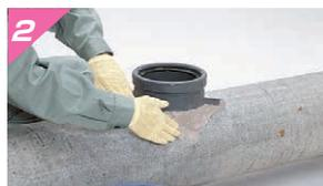
支管と本管接合部のすきまを接合剤で充填します。
