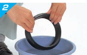
ゴム輪を洗浄するとともに、装着を容易にするため、水でゴム輪を濡らします。
