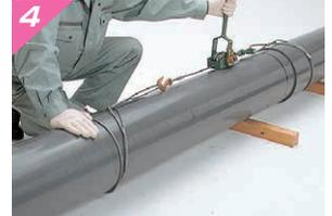
接着剤を塗り終わったら、直ちに管軸を合わせて標線まで一気に挿入し、そのまま保持します。※標準保持時間はP17参照
