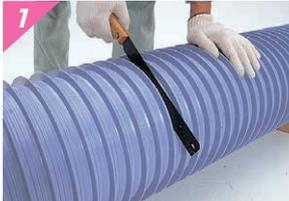
リップとリップの間(小リップの間)を手のこまたはサンダーで切断します。
