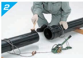
受口内面ゴム輪部、挿し口外面の順に、塗りムラのないよう円周方向に均一にVソープを塗布します。この時、挿し口は管端から標線まで全円周にわたって塗布してください。
