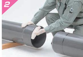
受口内面および挿し口外面を乾いたウエスなどで清掃します。なお挿入機およびワイヤー等は予めセットしておきます。
