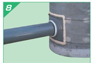
取付け後は、接着剤が硬化するまで外力がかからないよう静置してください。(写真はくら型マンホール可とう継手の場合)
