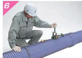
管軸を合わせて標線まで挿入します。
