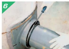
(くら型マンホール可とう継手のみ) マイナスドライバーでSUSバンドを締付け、管とゴム部を接合します。
