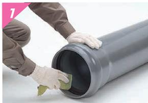
管受口内面および挿し口外面を乾いたウエスなどで清掃します。
