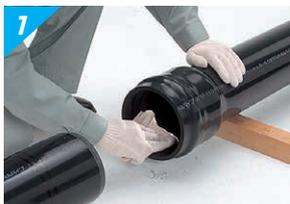
受口内面および挿し口外面を乾いたウエスなどで清掃します。
