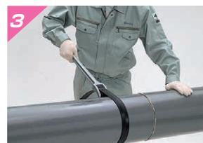
接合部を仮合わせした後、管軸を合わせてベルトレンチにて管を回しながら一気にねじ込みます。接合部外面に1mm程度の隙間ができるのが正常な状態です。
