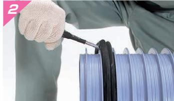
ゴム輪の表裏を確認し、管端から数えて2番目と3番目のリップの間にゴム輪を装着します。
