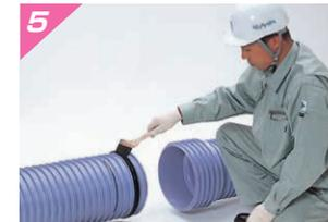
受口内面、挿し口ゴム輪の順に、塗りムラのないよう円周方向に均一にVソープを塗布します。
