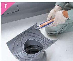
支管のくら裏面および本管の支管取付け範囲内を清掃し、SVR接着剤を写真のように均一に塗布します。
