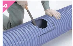
ヤスリ等でバリを取り、管内の塩ビくずを取除きます。
