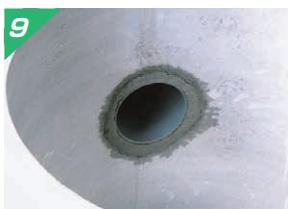
配管後にマンホール穿孔穴と本管のすきまを、モルタル、KCケーシーボンドIIなどで充填してください。
