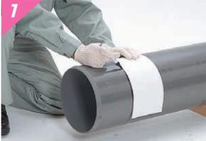
挿し口に挿入長さを示す標線をマジックインキで記入します。
