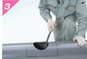
ヤスリ等でバリを取り、管内の塩ビくずを取除きます。
