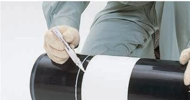
管端の仕上げができると、管挿し口に挿入長さを表す標線をマジックインキなどで記入します。標線はできるだけ管の全周にわたって記入します。
