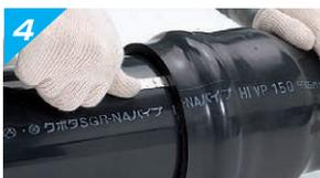
管挿入後、全円周にわたってゴム輪が正常な状態かどうかチェックゲージで確認します。異常が認められた場合は直ちに管を抜き、作業をやり直してください。
