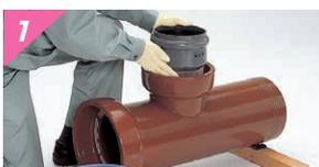
支管を受口に据付け、接合部を水で濡らします。
