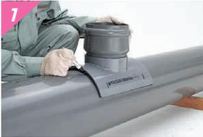
穿孔位置を決めて支管を仮置きし、支管取付位置に標線を記入します。また位置がずれないようにマークも記入します。
