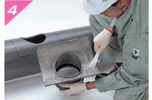
混練したタフタイトEPSを支管のくら裏面に均一に塗布します。
