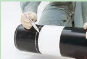
Setelah menyelesaikan pembubutan tepi pipa, gambar garis penanda di sekeliling ujung pipa yang akan dimasukkan menggunakan spidol untuk menunjukkan panjang kedalaman masuk. Gambar garis di permukaan pipa, di tempat yang memungkinkan.
