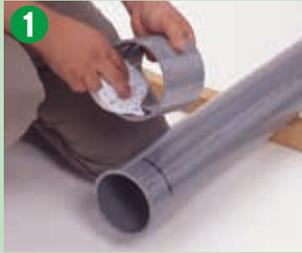
Bersihkan permukaan bagian dalam fitting dan permukaan luar ujung pipa yang akan dimasukkan menggunakan kain kering.
