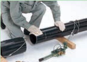
Bersihkan permukaan dalam fitting dan permukaan luar ujung pipa yang akan dimasukkan menggunakan kain kering. Posisikan kabel dan fastener sebelumnya.
