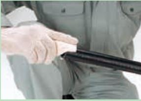
Bersihkan permukaan dalam fitting dan permukaan luar ujung pipa yang akan dimasukkan menggunakan kain kering.
