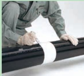
Gambar garis potong di sekeliling pipa, menggunakan selembar kertas tebal yang lebar atau plester.
