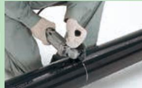
Pemotongan dengan gergaji pipa PVC.
