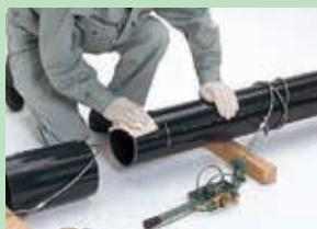
Bersihkan permukaan dalam fitting dan permukaan luar ujung pipa yang akan dimasukkan menggunakan kain kering. Posisikan kabel dan fastener sebelumnya.
