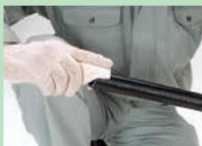
Bersihkan permukaan dalam fitting dan permukaan luar ujung pipa yang akan dimasukkan menggunakan kain kering.
