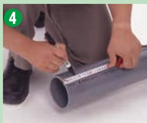
4 Setelah meruncingkan ujung pipa, ukur panjang masukan fitting dan gambar garis penanda dengan pena berbasis minyak.
