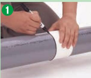
1 Menentukan di mana bagian pipa yang akan dipotong, dengan mempertimbangkan panjang kedalaman fitting. Gambar garis potong udara di sekitar pipa dengan pena berbasis minyak untuk memastikan bahwa pipa akan dipotong pada sudut yang tepat terhadap sumbu membujur dari pipa. Gunakan selembar kertas besar atau plester ketika menggambar garis.
