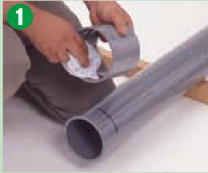
**1** Bersihkan permukaan bagian dalam fitting dan permukaan luar ujung pipa yang akan dimasukkan menggunakan kain kering. Bersihkan minyak yang ada pada pipa dengan thinner. Pastikan bahwa ujung pipa telah diperbaiki dan garis penanda yang menunjukkan panjang kedalaman telah digambar pada pipa.
