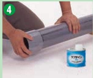
**4** Setelah menyambungkannya, selalu pertahankan tenaga untuk menahan fitting dan pipa bersama-sama sementara waktu. Jika tidak, pipa dapat terlepas dari fitting karena permukaan dalam fitting yang meruncing. Waktu penahanan sambungan bervariasi pada jumlah perekat yang dioleskan, toleransi dimensional, dan suhu. Waktu penahanan sambungan yang dibutuhkan pada umumnya ditunjukkan pada tabel di bawah ini. Setelah itu, segera bersihkan perekat yang keluar ke permukaan sambungan.
