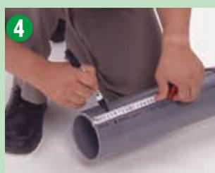
Setelah meruncingkan ujung pipa, ukur panjang masukan fitting dan gambar garis penanda dengan pena berbasis minyak.
