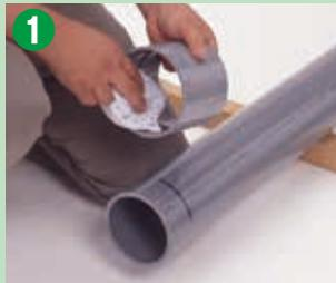
Bersihkan permukaan bagian dalam fitting dan permukaan luar ujung pipa yang akan dimasukkan menggunakan kain kering.
