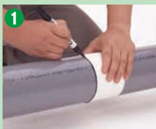
Menentukan di mana bagian pipa yang akan dipotong, dengan mempertimbangkan panjang kedalaman fitting. Gambar garis potong udara di sekitar pipa dengan pena berbasis minyak untuk memastikan bahwa pipa akan dipotong pada sudut yang tepat terhadap sumbu membujur dari pipa. Gunakan selerbar kertas besar atau plester ketika menggambar garis.
