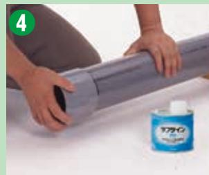
Setelah menyambungkannya, selalu pertahankan tenaga untuk menahan fitting dan pipa bersama-sama sementara waktu. Jika tidak, pipa dapat terlepas dari fitting karena permukaan dalam fitting yang meruncing. Waktu penahanan sambungan bervariasi pada jumlah perekat yang dioleskan, toleransi dimensional, dan suhu. Waktu penahanan sambungan yang dibutuhkan pada umumnya ditunjukkan pada tabel di bawah ini. Setelah itu, segera bersihkan perekat yang keluar ke permukaan sambungan.
