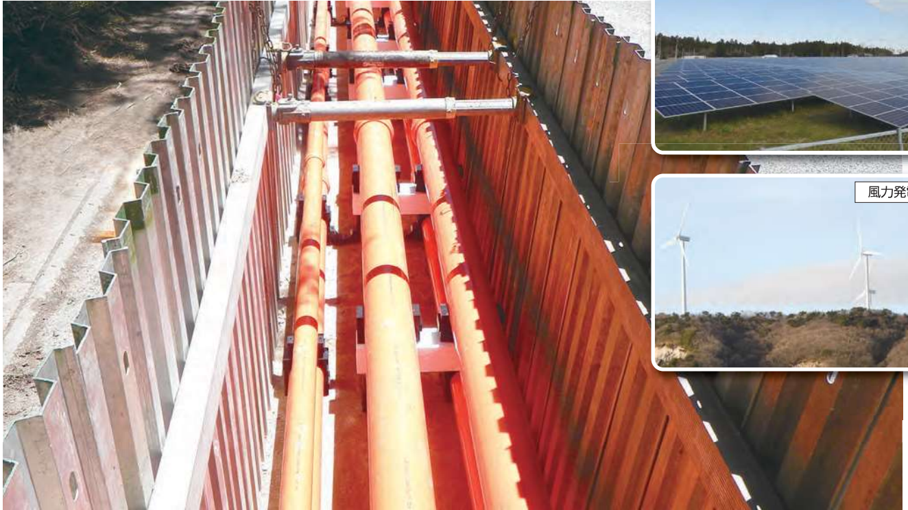
阿武隈北部送電ルート(山側)での配管完了のようす
