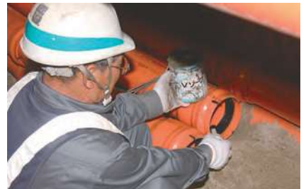
挿し口外面と受口のゴム輪に滑剤を塗布する。
