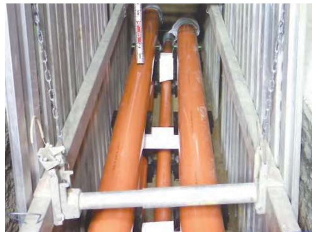
完成した送電線の保護管路(電力ケーブル保護管)
